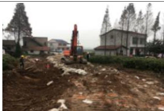
村口新增二期进场道路铺筑
