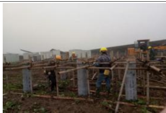
二期 B03 区箱逆变平台支模
