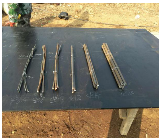
升压站钢筋见证取样
