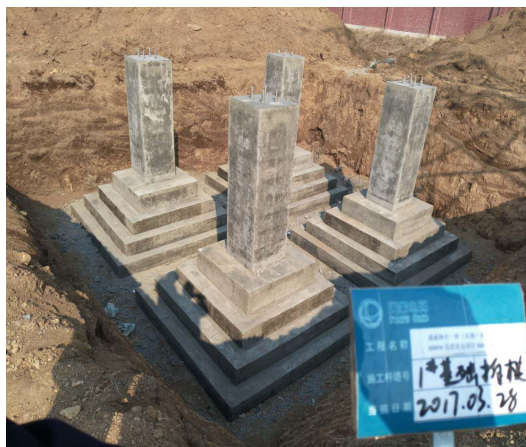
塔基混凝土
