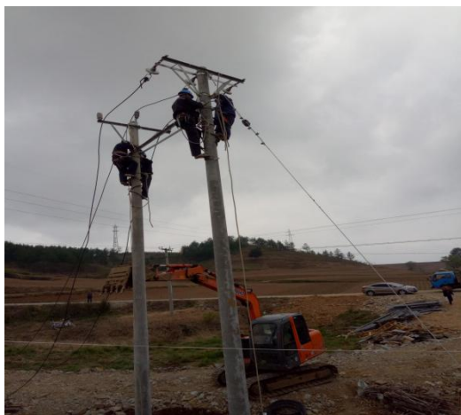
10KV站用电网架设
