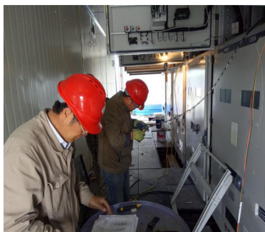
二次舱内接线
