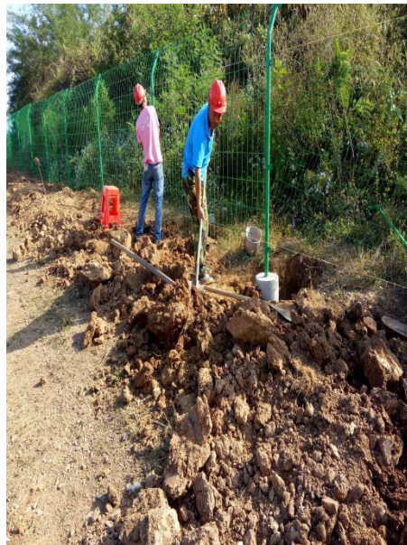
围栏基础人工回填
