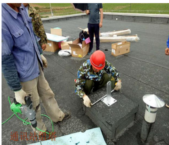
通讯基站施工
