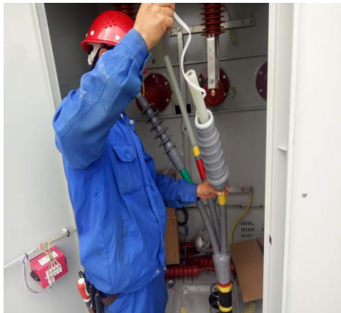
高压电缆终端制作
