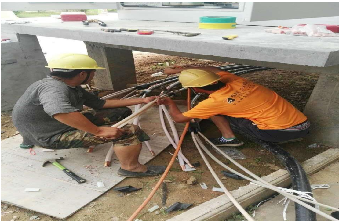
箱变接线施工
