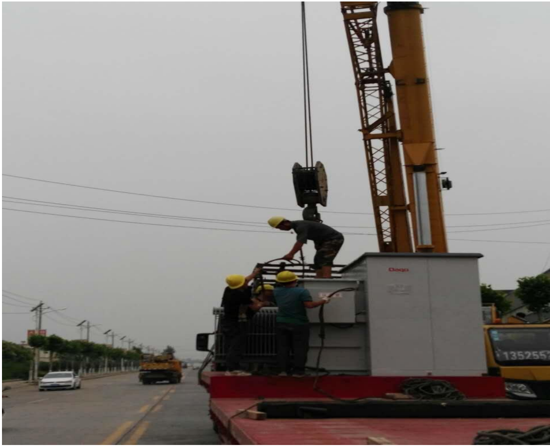
箱变接线施工
