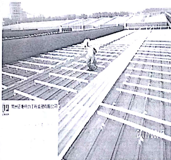
2 期 2#厂房导轨安装
