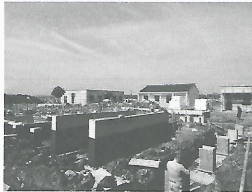
综合区主体结构完成
