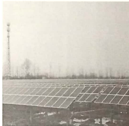
4#方阵组件安装完成
