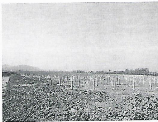
1#、2#、3#、4#、5#方阵支架安装
