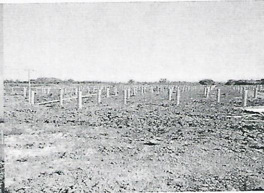
10#、11#方阵桩基完成 95%
