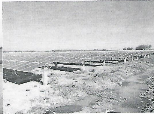
7#-8#方阵光伏组件安装完成
