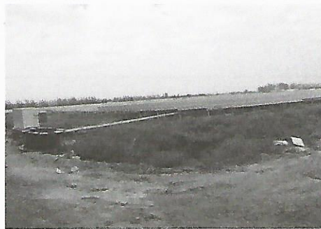
3#方阵光伏组件安装完成
