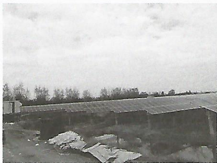
5#方阵光伏组件安装完成
