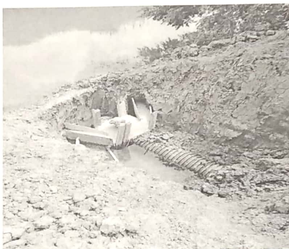
排污管、蝶阀安装完成
