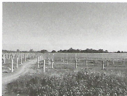
10# 方阵支架横条安装
