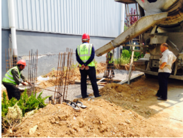
5月16日浇筑裕 龙1至4#箱逆变 设备基础底板；
