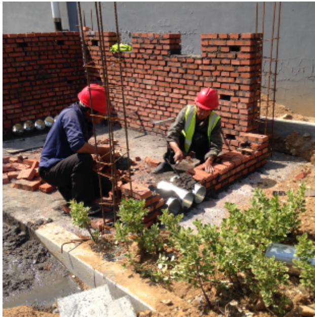
5月17日裕龙厂 区各个箱逆变 设备基础墙体 砌筑施工；
