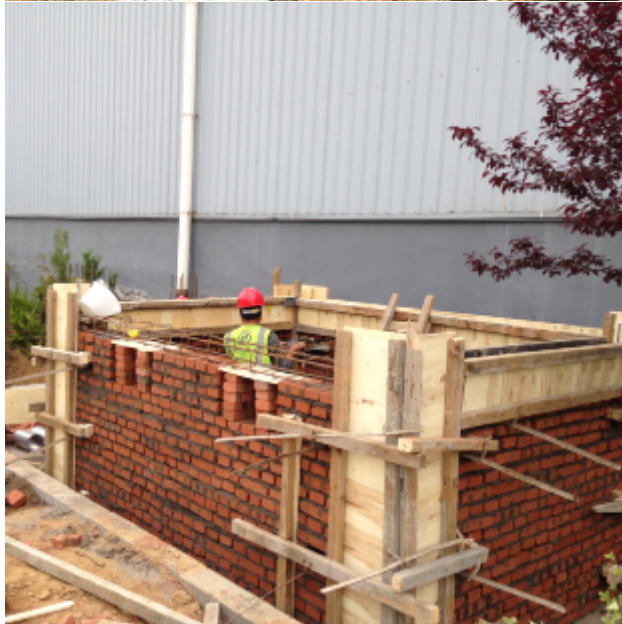
5月20日裕龙1 #逆变, 2、3#箱 逆变设备基础 梁板柱钢筋模 板施工；
