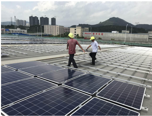
3#厂房屋面组件搬运
