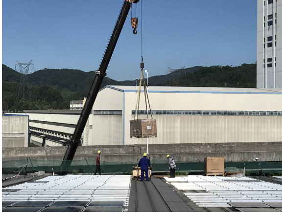
3#厂房屋面组件吊装
