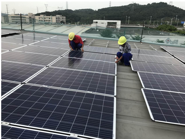
3#厂房屋面组件安装
