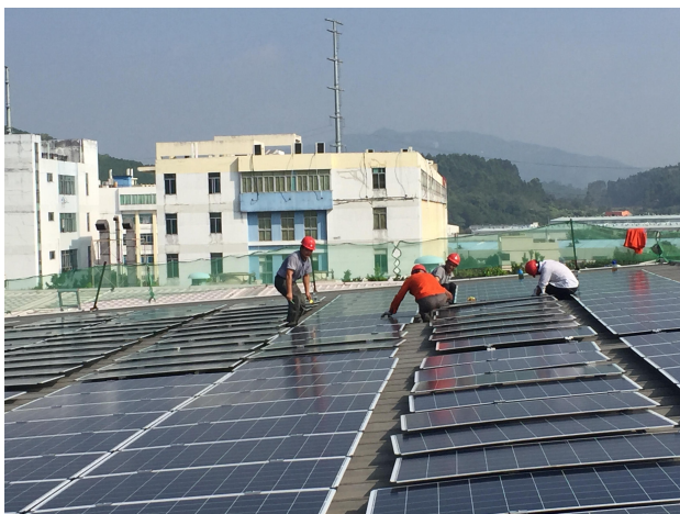
2#屋面组件安装
