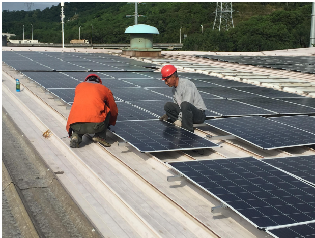
1#屋面组件安装
