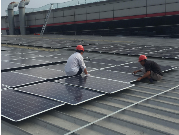
4#屋面组件安装
