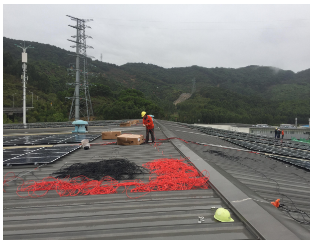
屋面电缆敷设
