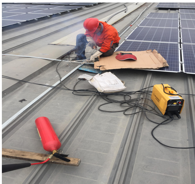
屋面接地焊接
