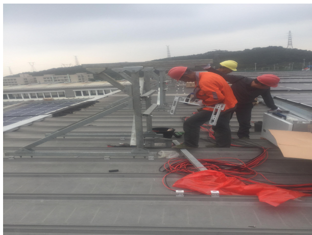
3#屋面逆变器支架安装
