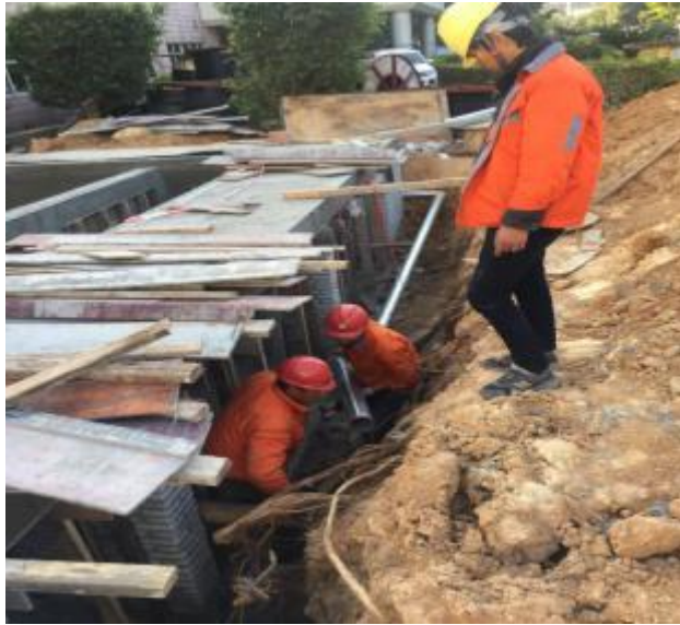
消防水管改道施工
