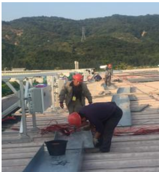
屋面桥架安装
