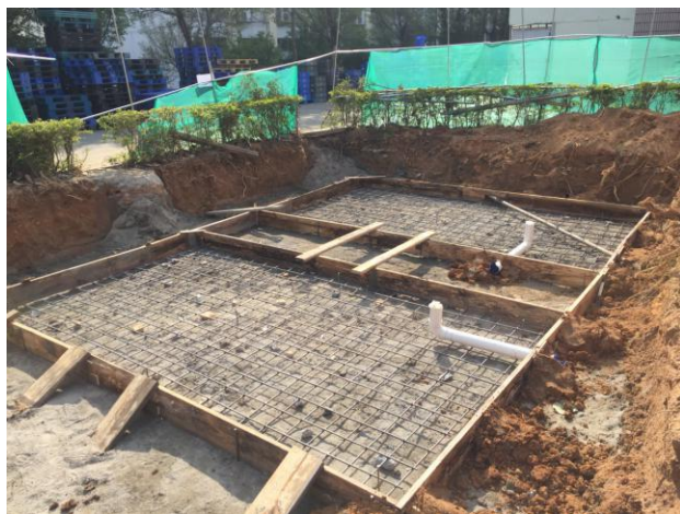
箱变基础钢筋绑扎
