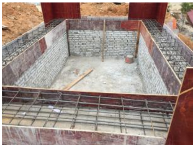
SVG 圈梁钢筋绑扎
