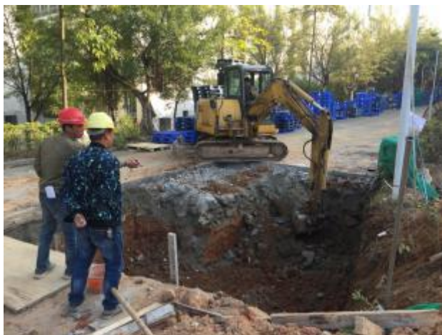
电缆转角井基坑开挖
