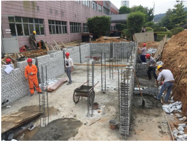
预制仓墙体砌筑
