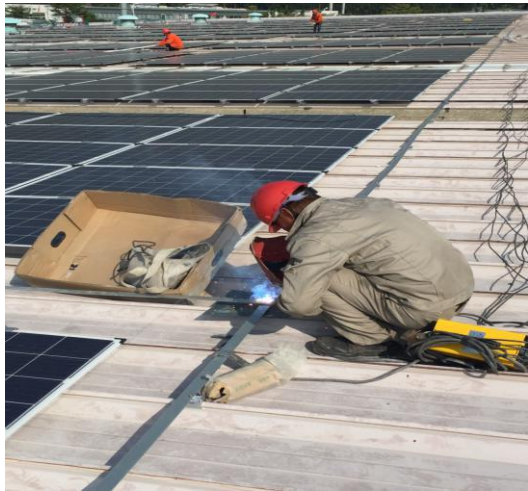
屋面接地焊接
