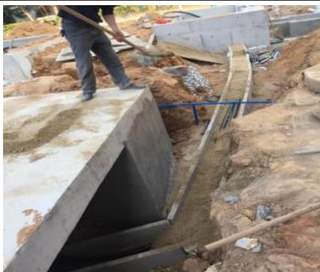
电缆槽盒填砂施工
