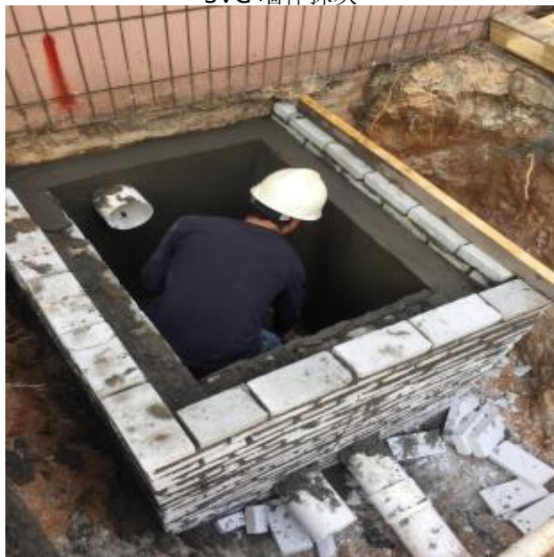
电缆直线井施工
