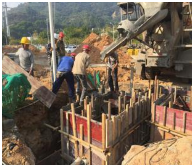
电缆井混凝土浇筑
