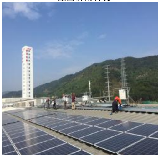
屋面电缆敷设
