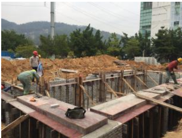
预制仓梁、柱、板模板安装
