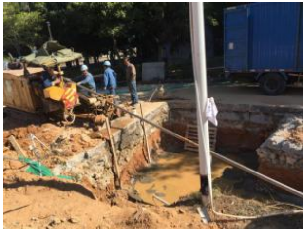
顶管施工
