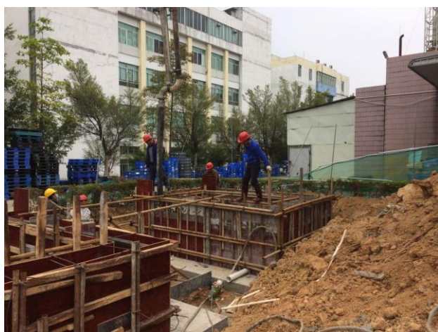
箱变基础浇筑
