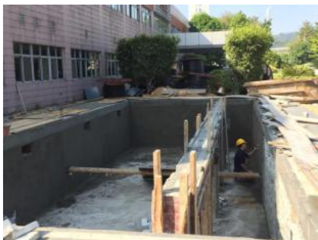
预制仓基础墙体抹灰
