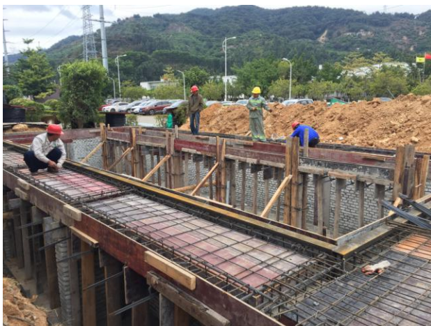
预制仓梁板钢筋绑扎
