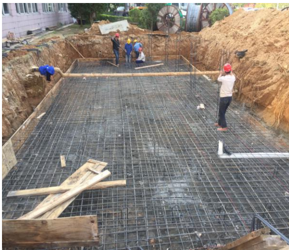
预制仓筏板基础钢筋绑扎
