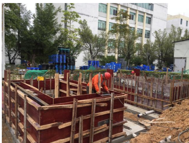
箱变基础模板安装
