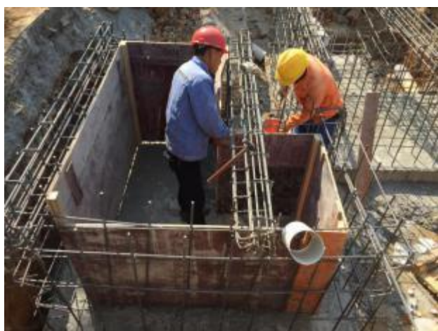
电缆转角井模板安装
