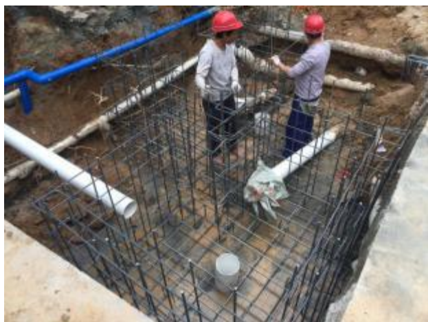
电缆转角井钢筋绑扎
