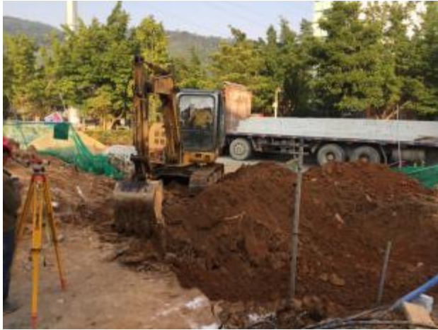
SVG 基础开挖
