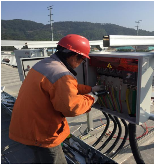
汇流箱接线施工
