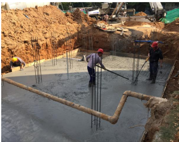
预制仓筏板基础浇筑
