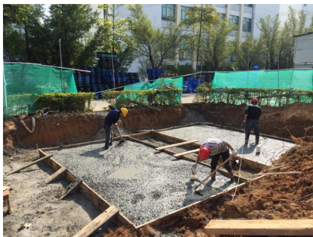
箱变基础筏板浇筑
