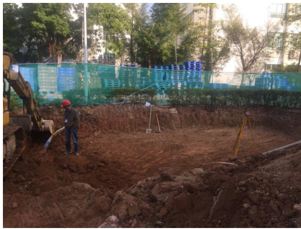
箱变基础开挖
