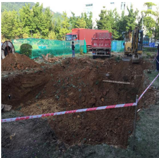
预制仓基础开挖
