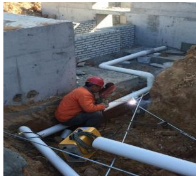
设备基础接地网焊接
