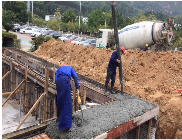
预制仓梁板混凝土浇筑
