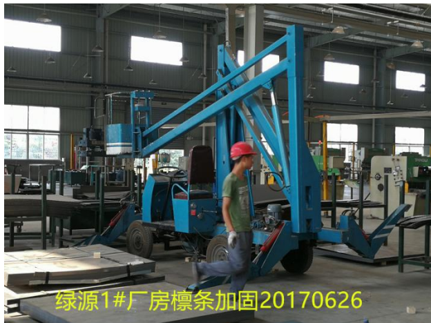
绿源加固处涂刷20170624
