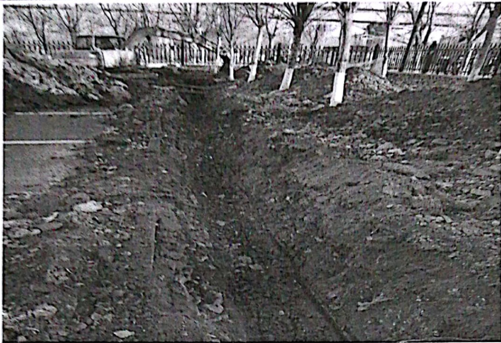
北区电缆沟开挖
