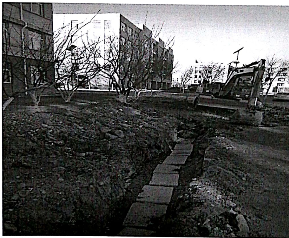
北区电缆沟回填
