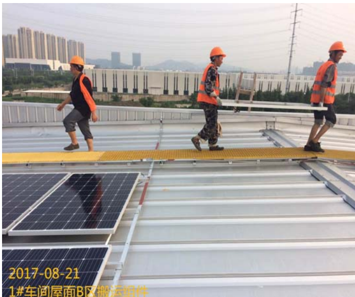
12、按时代新能源厂方审核通过的《溧阳时代新能源组件安装作业指导书》上的要求，对1#车间屋面上组件的吊装、搬运、摆放进行施工。
