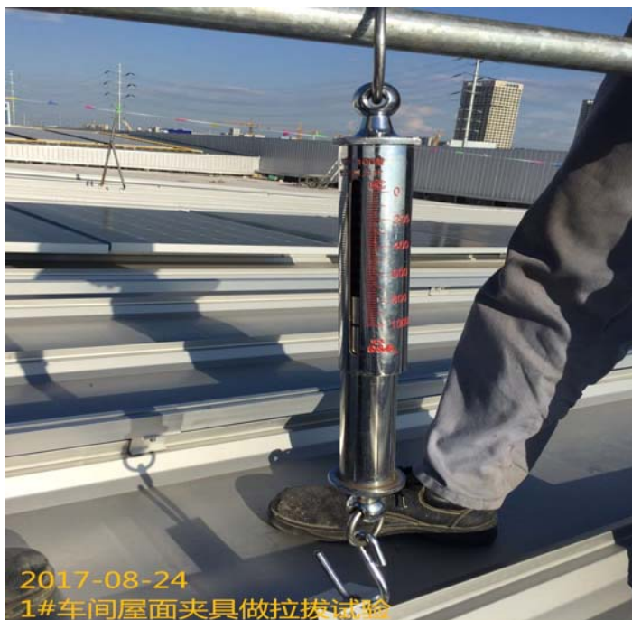
9、1#车间屋面夹具的拉拔试验完成;
