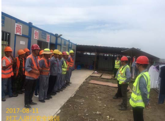
10、本月对工人进行的安全培训及正确使用灭火器进行灭火演练
