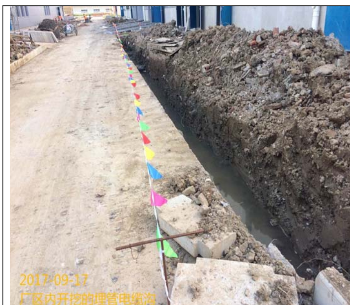
9、箱变出线电缆沟开挖完成20%
