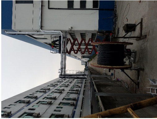
下挂至箱变位置电缆桥架施工（问题项正在整改）
