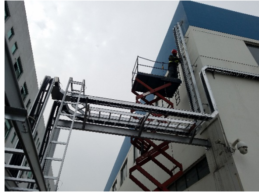
下挂至箱变位置电缆桥架施工（问题项正在整改）
