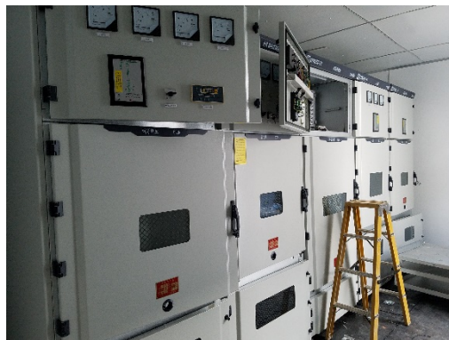
一次二次设备电气连接及试调试
