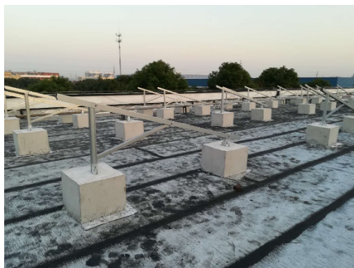
03 混凝土屋面组件支架基础工程
