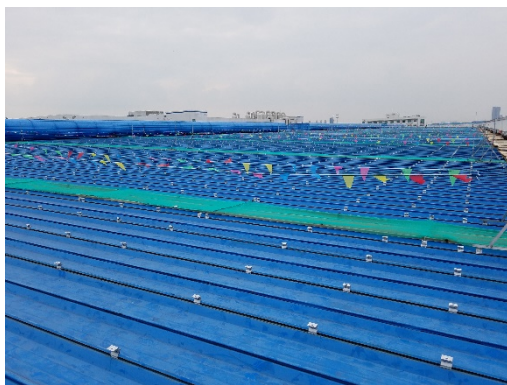
03 混凝土屋面组件支架基础工程
