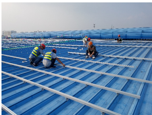
04 彩钢瓦屋面组件支架基础工程
