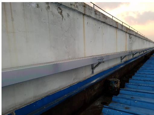
05 电缆桥架安装
