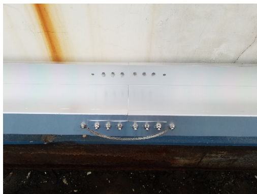
05 电缆桥架安装
