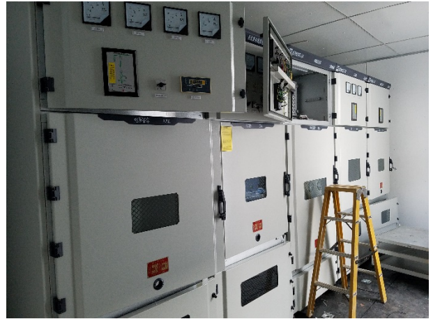
05 箱变、预制舱设备进场检查
