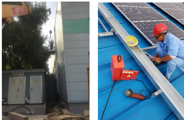
电缆桥架施工
