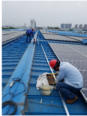
05 防雷接地扁钢焊接
