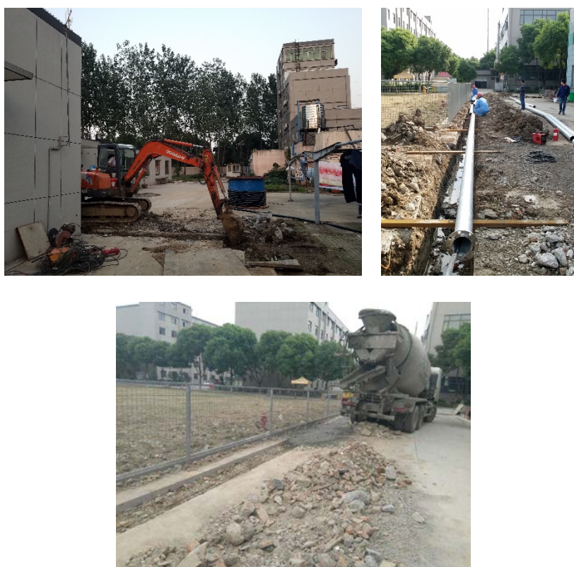
过路电缆施工
