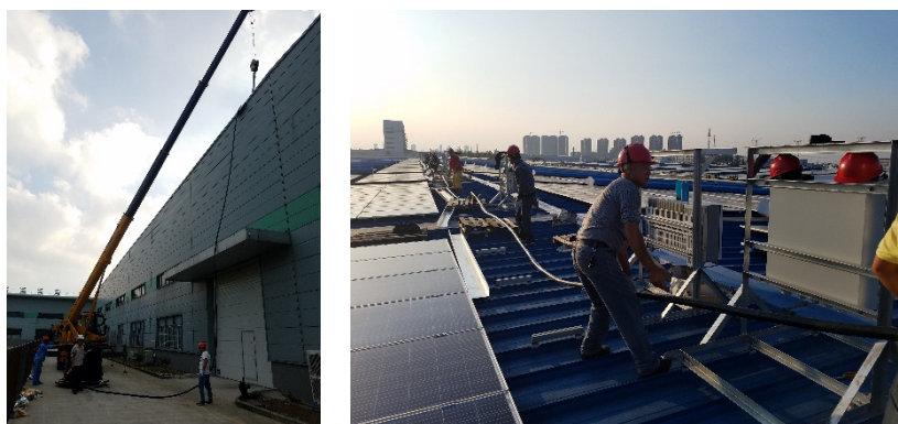
电缆桥架施工
