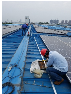
05 防雷接地扁钢焊接
