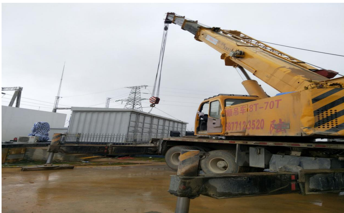
升压站一、二次舱舱体进行重新改造
