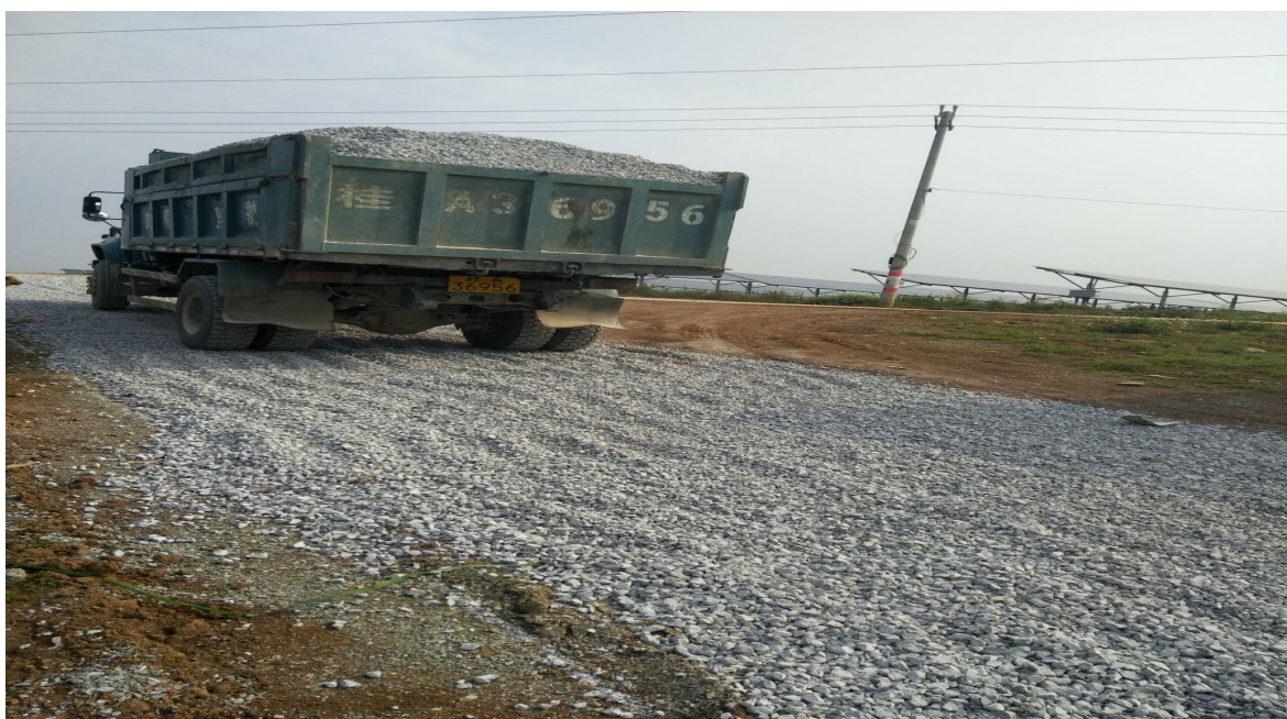
光伏场区道路施工
