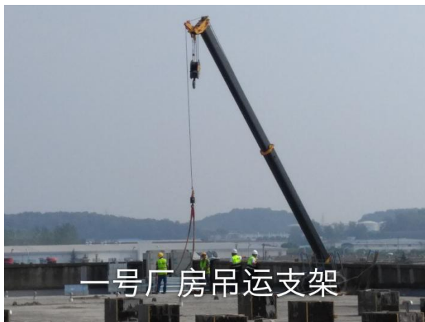
一号厂区支架 吊装
