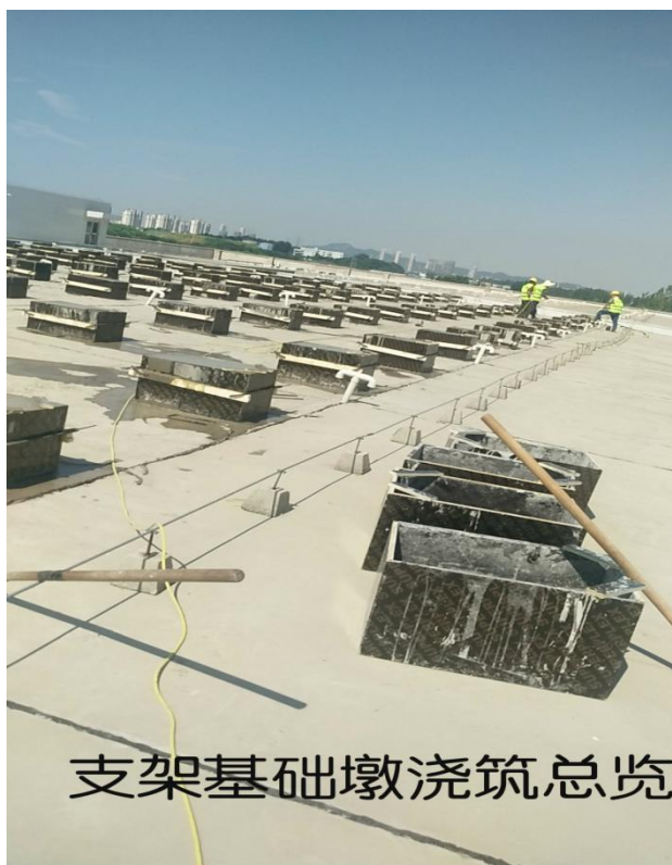
新南三屋面支 架基础墩浇筑 完成
