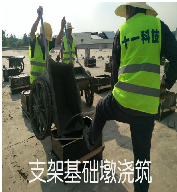
新南三屋面支 架基础墩浇筑
