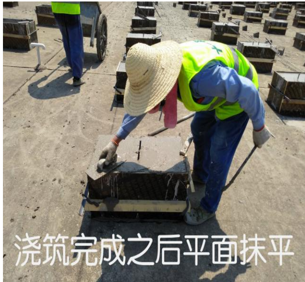
浇筑完成之后 平面抹平
