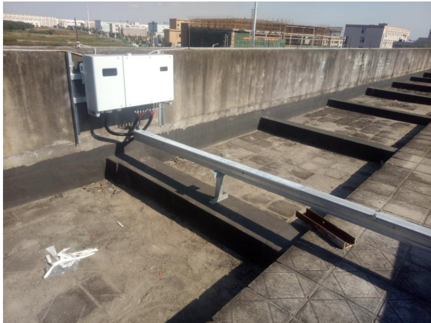
誉丰 2 号屋面逆变器接线完成
