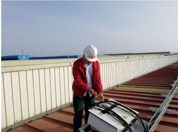
检查 mc4 接头连接情况
