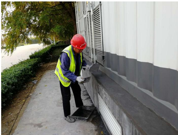
箱变基础二次抹灰找平
