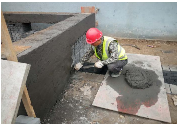
箱变基础抹灰
