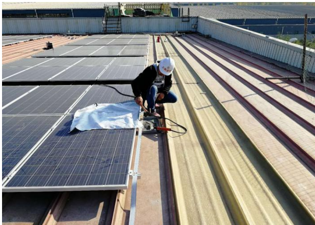
检查接地网焊接情况
