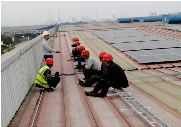
对现场工作人员进行 技术交底
