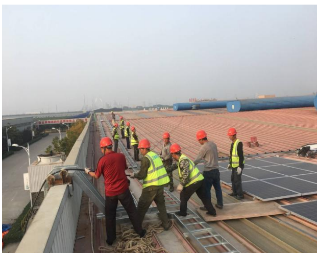
光伏电缆铺设
