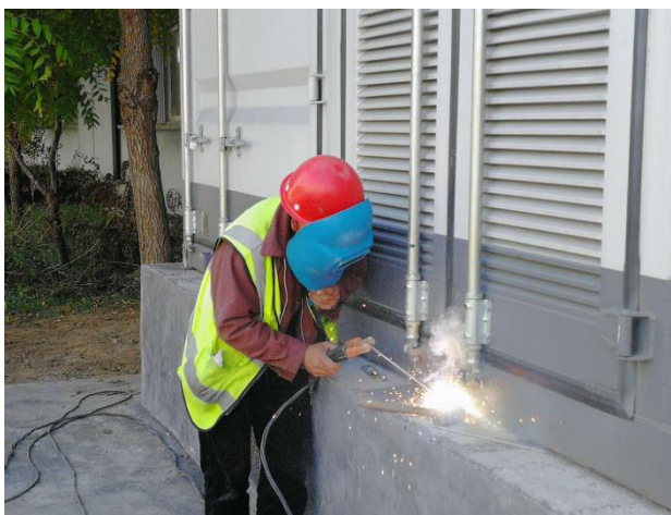
焊接箱变接地
