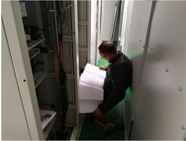
二次舱接线检查
