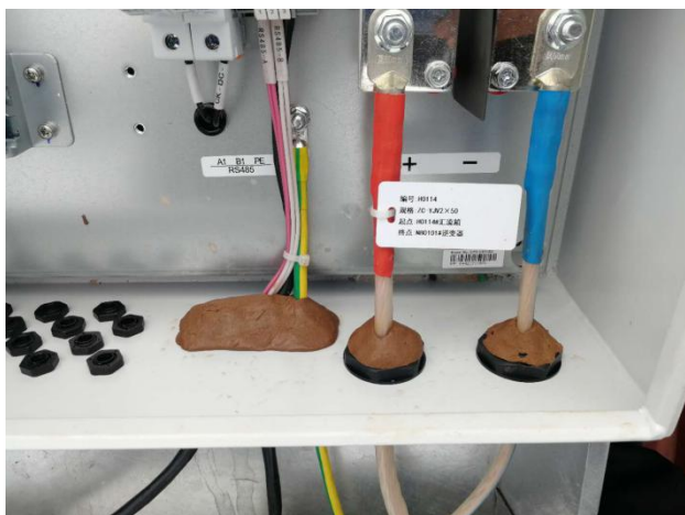
汇流箱防火封堵及电 缆挂牌
