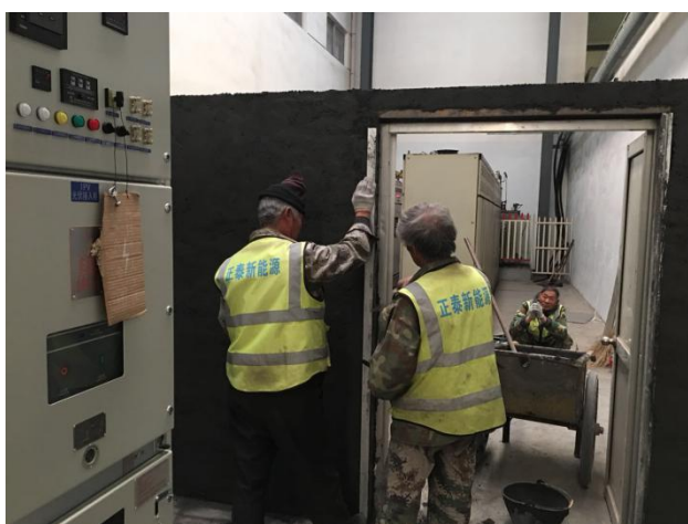
配电室墙体粉刷
