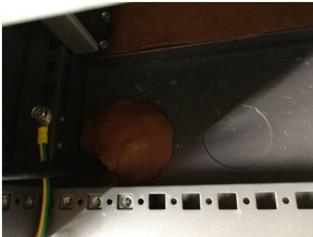
逆变器防火封堵
