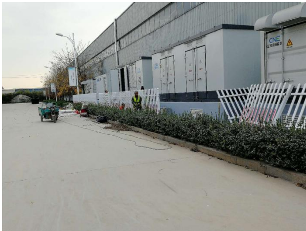
安装箱变防护栏
