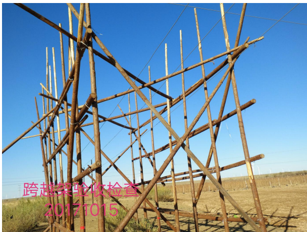
跨越架验收检查
