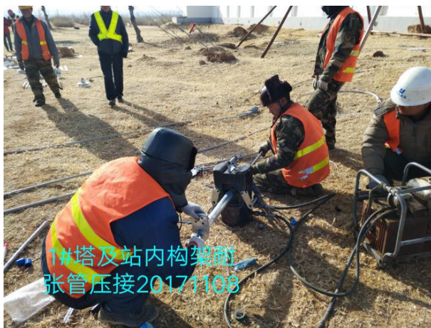
1#塔耐张管压接旁站
