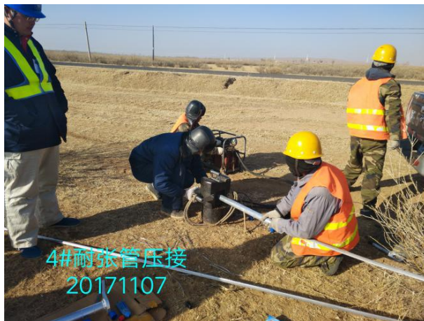
耐张管压接现场旁站
