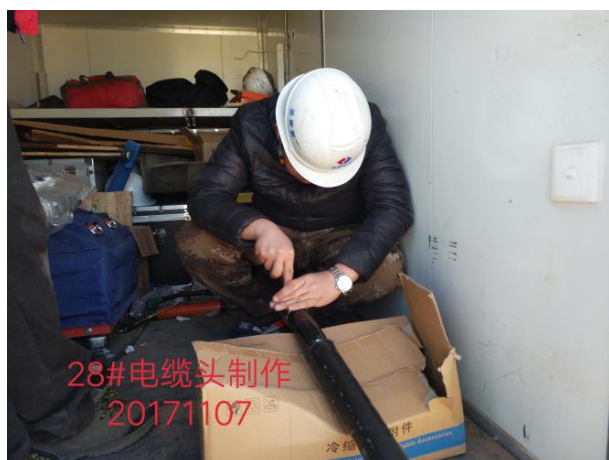
电缆头制作现场旁站检查
