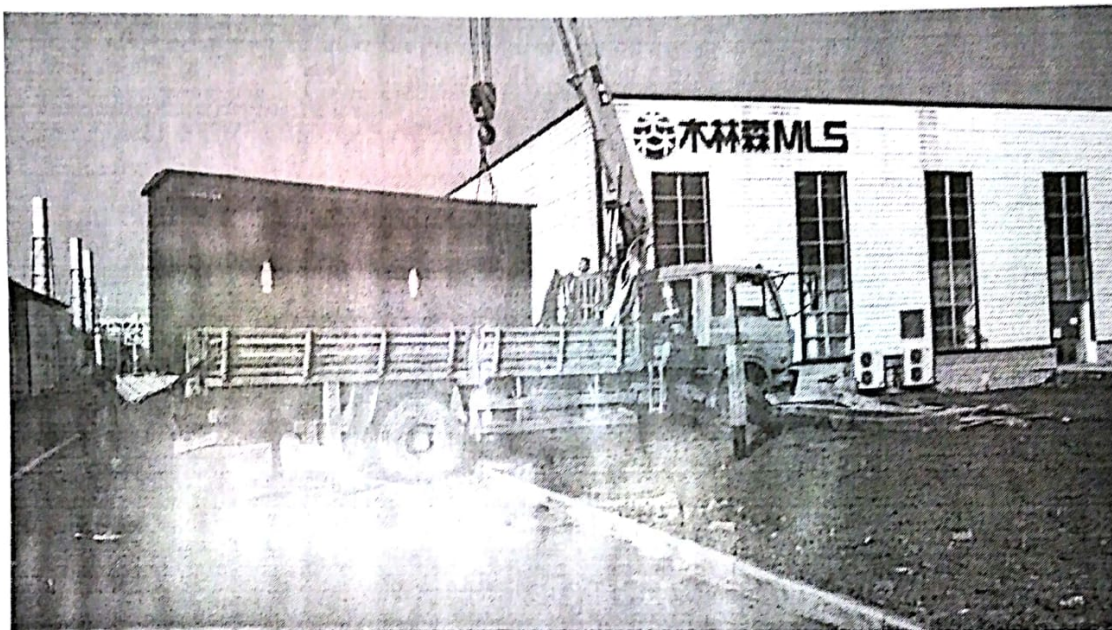
三期厂房内高压电缆分接箱设备吊装
