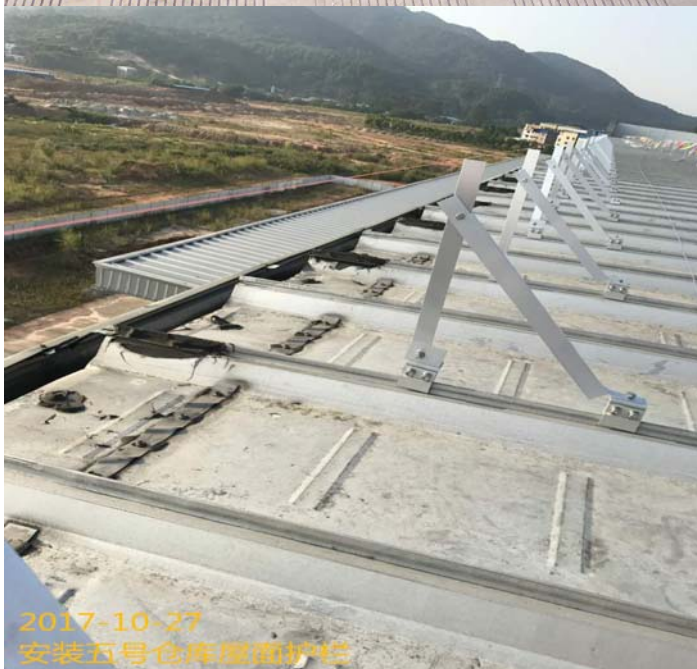
6、屋面护栏支架安装；
