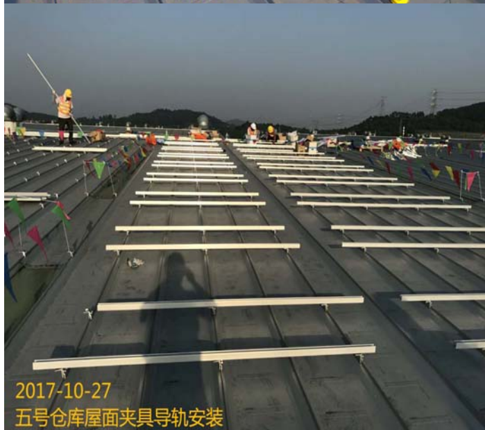
7、仓库屋面夹具及导轨安装;
