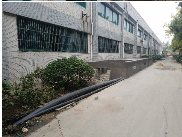
05 箱变基础土建工程
