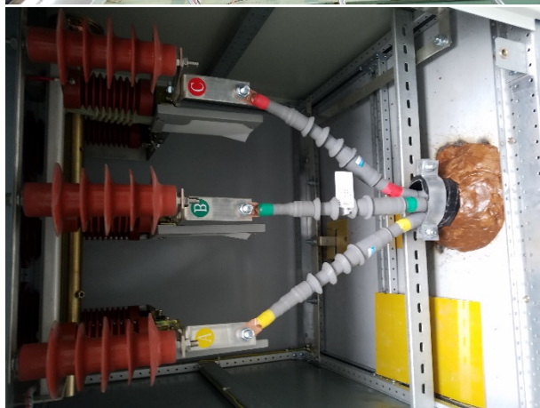
10 电缆敷设及电气连接
