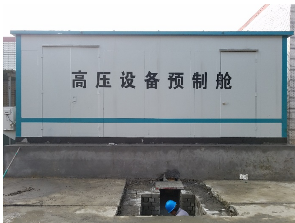
08 箱变、预制舱吊装就位
