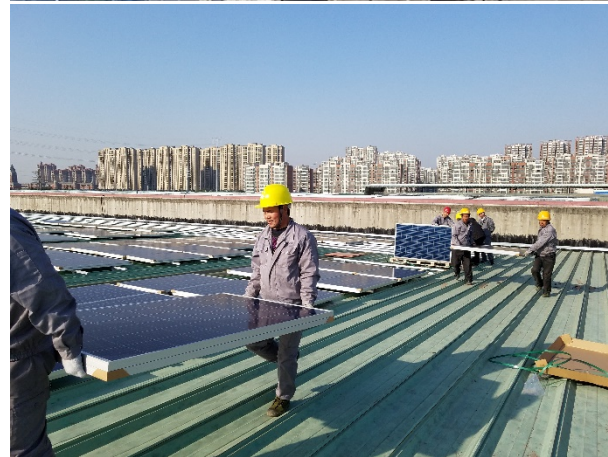
07 支架材料、混凝土配重块、组件吊装
