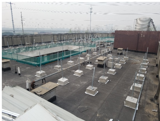
03 混凝土屋面组件支架基础工程
