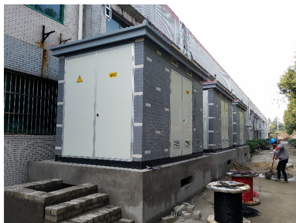
08 箱变、预制舱吊装就位
