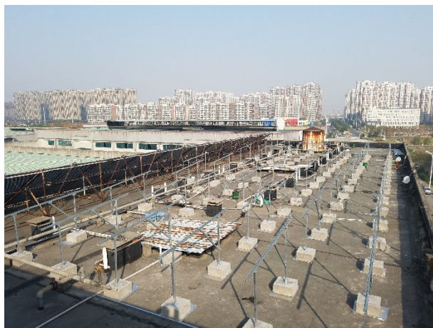
03 混凝土屋面组件支架基础工程
