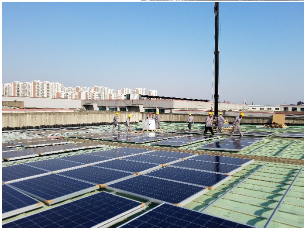
07 支架材料、混凝土配重块、组件吊装
