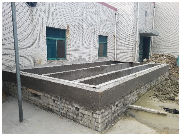
06 预制舱基础土建工程
