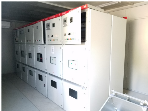
12 一次二次设备安装调试及实验
