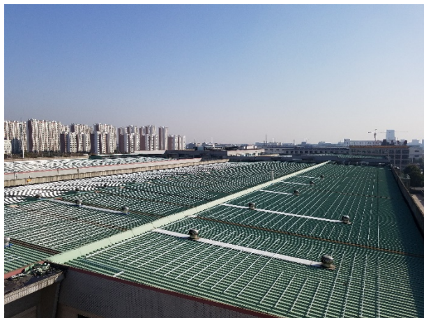
04 彩钢瓦屋面组件支架基础工程
