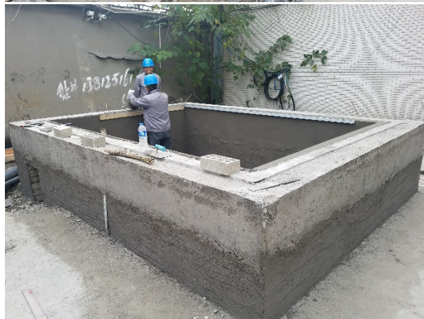
05 箱变基础土建工程
