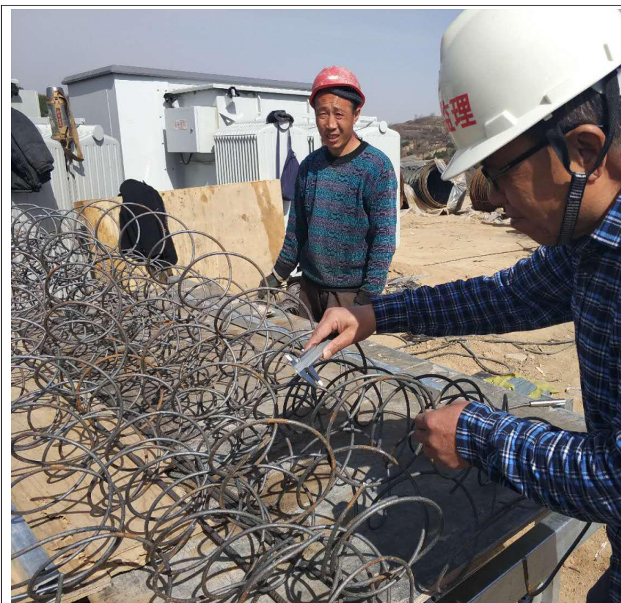
桩基钢筋笼制作检查
