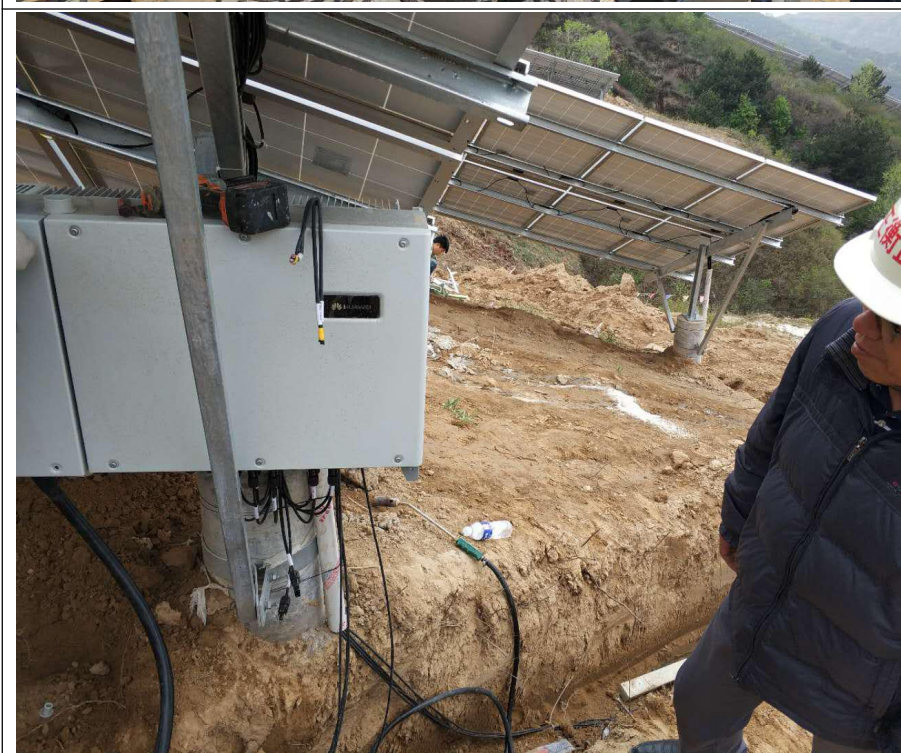
逆变器安装 检查
