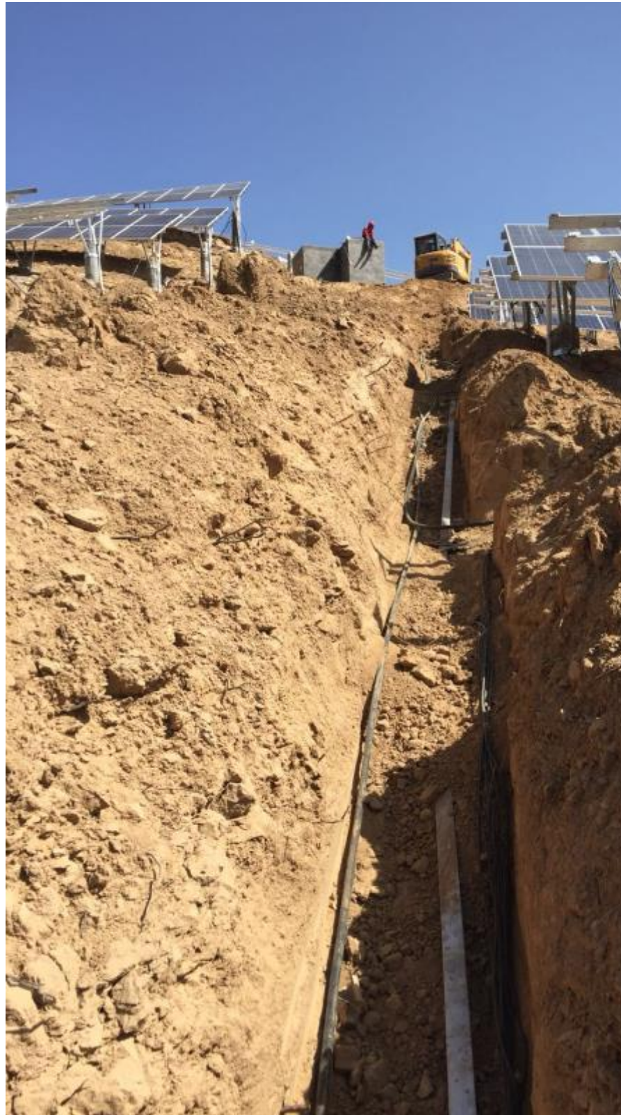
8 区 电 缆 沟 回 填
