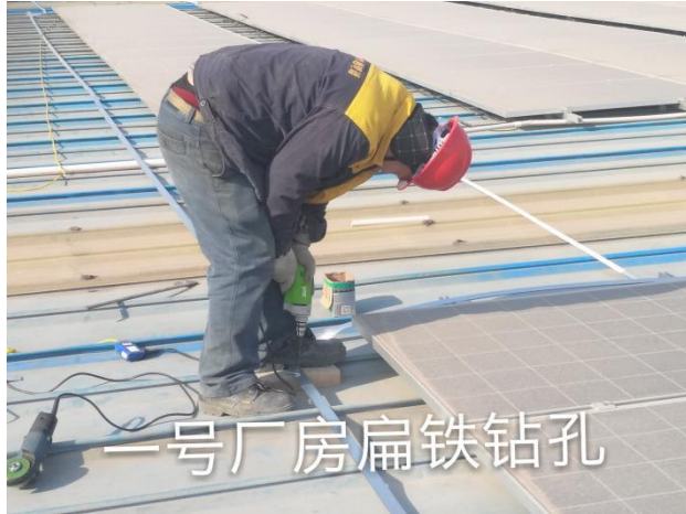
一号厂房扁铁 钻孔
