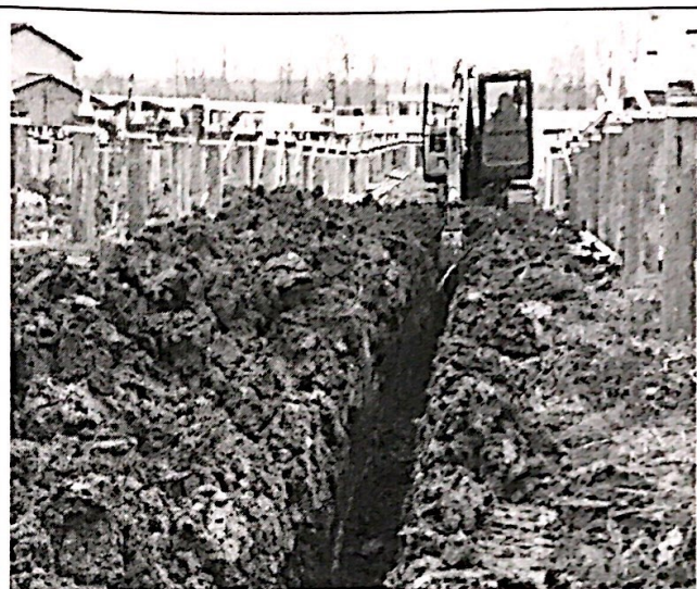
40 区电缆沟开挖
