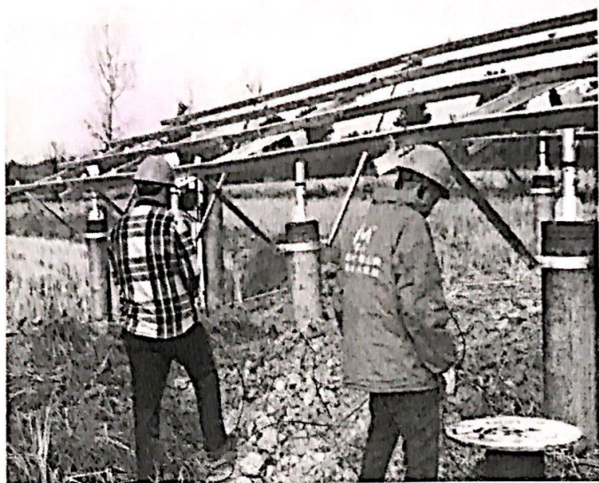
39 区光伏电缆敷设
