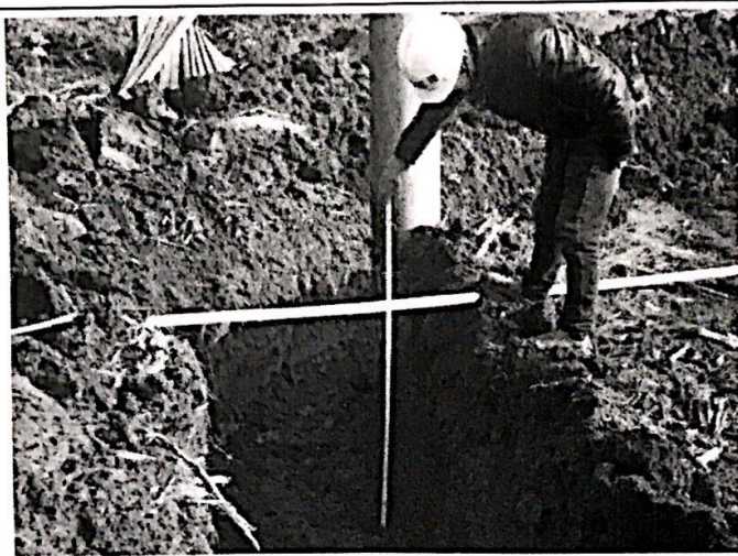
检查接地沟开挖深度
