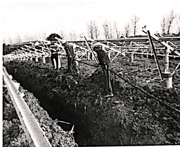
38 区直流电缆敷设
