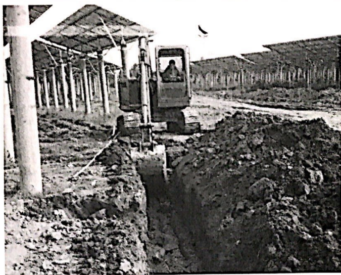
33 区接地沟开挖
