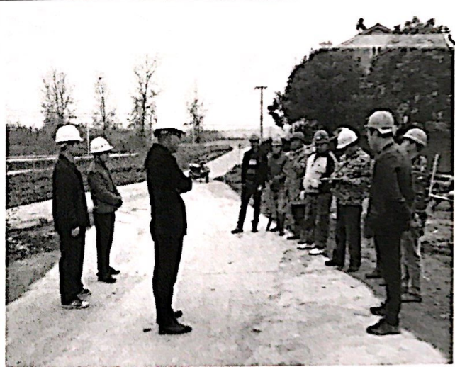
现场对消缺人员做安全技术交底
