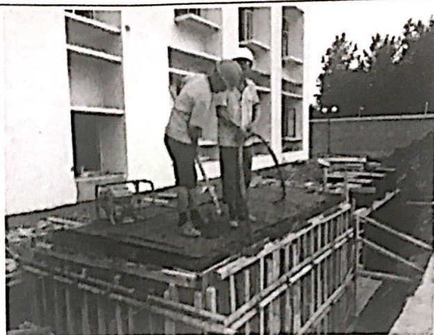
污水池基础混凝土浇筑
