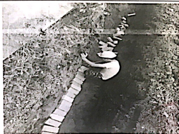
24 区电缆沟铺砂盖砖
