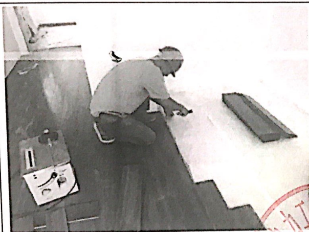
综合楼地板铺设
