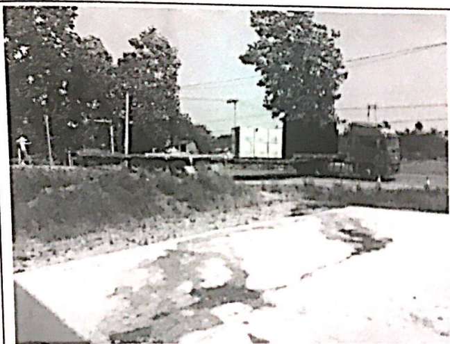
综合楼污水设备到货
