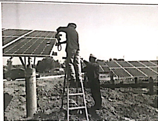
23 区边压块更换
