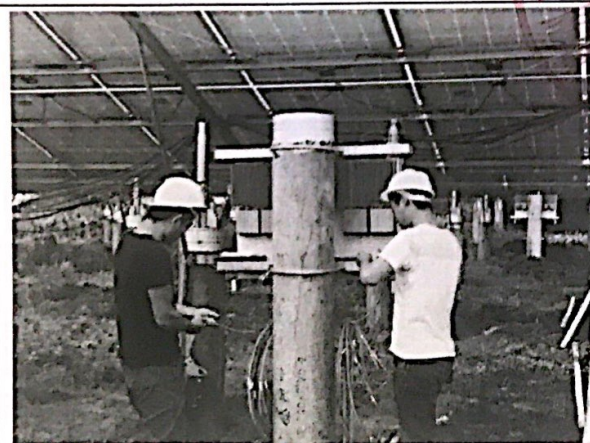
26 区汇流箱接线施工
