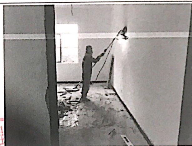
综合楼刮白施工
