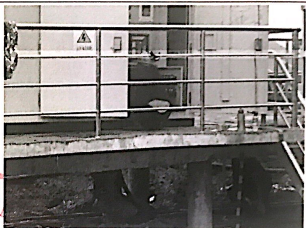
26#箱逆变电缆接头制作
