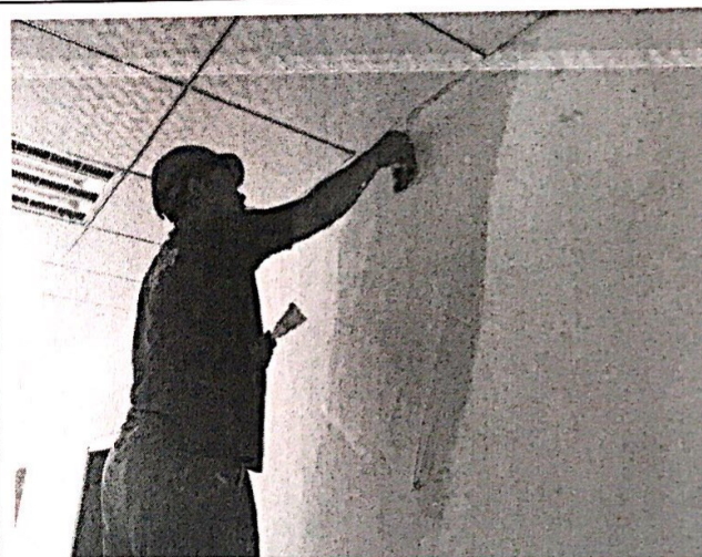
综合楼墙面修补
