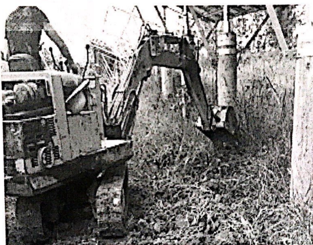
16 区电缆沟回填
