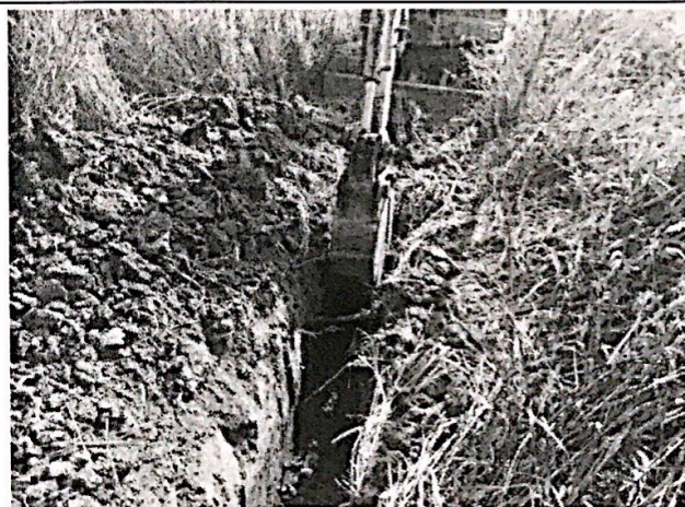
29 区接地沟开挖
