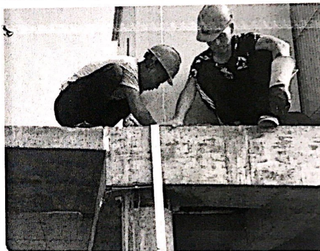
32#箱逆变平台接地焊接
