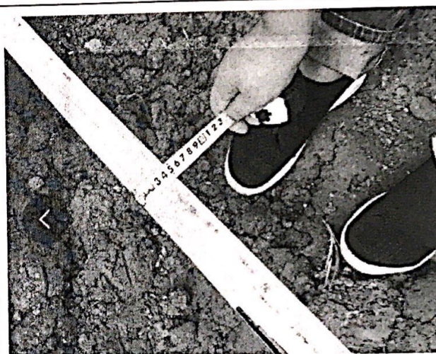
检查接地扁铁规格
