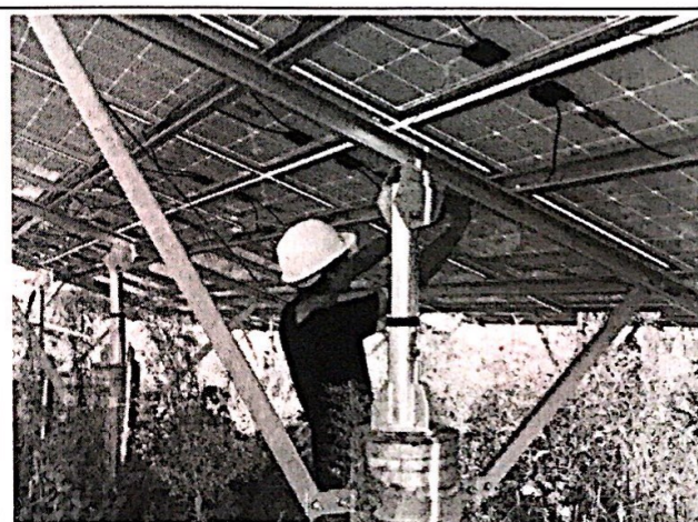
1 区电气消缺整改
