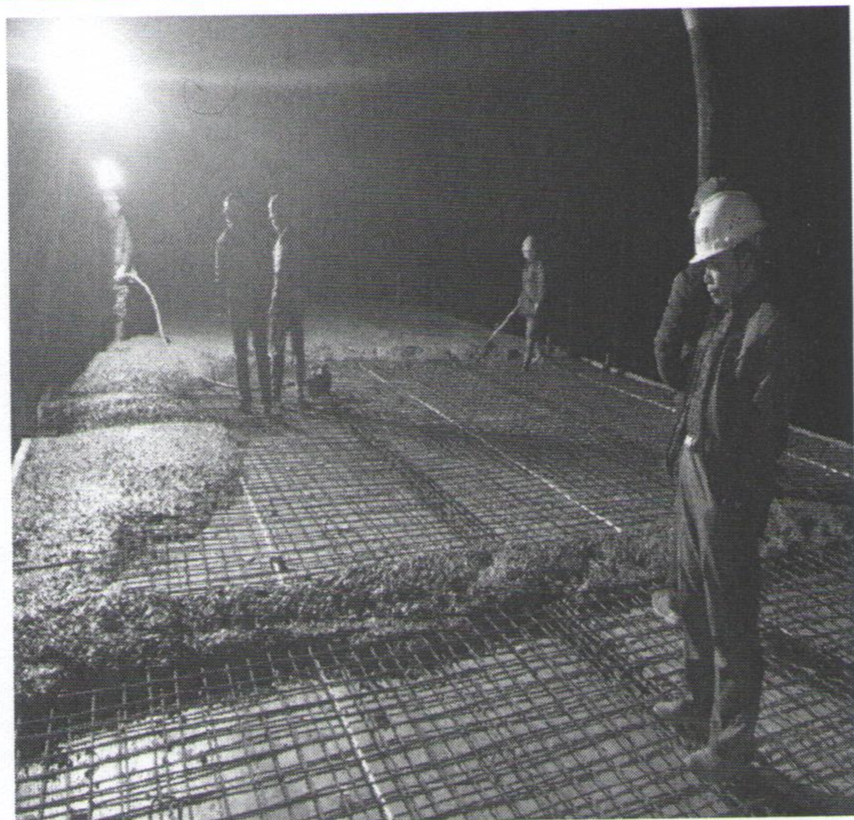
配电楼屋顶浇筑
