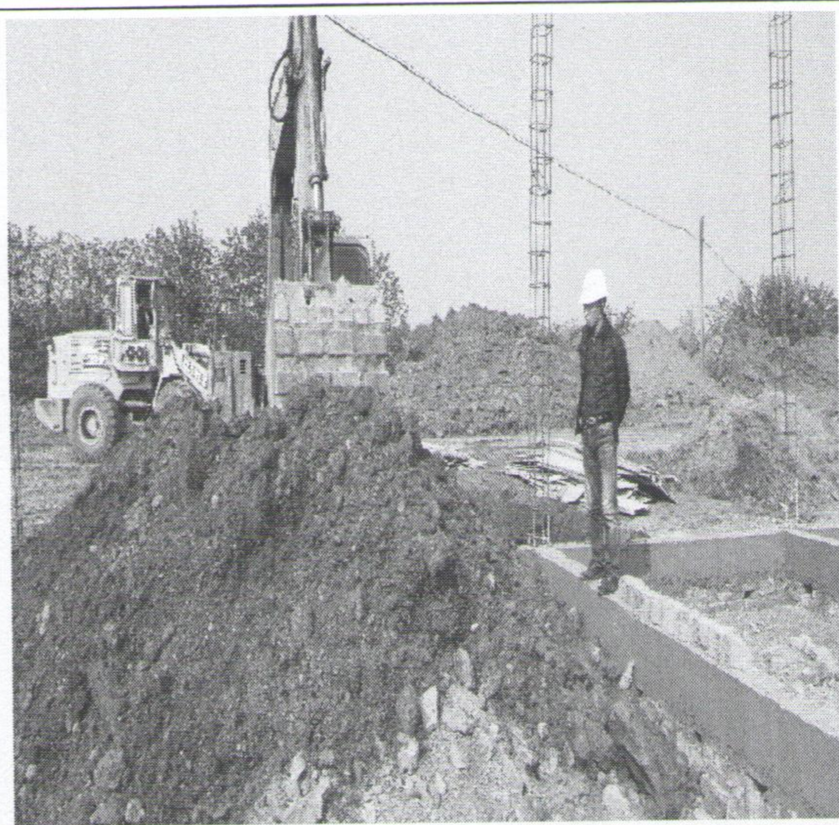
配电楼基础回填
