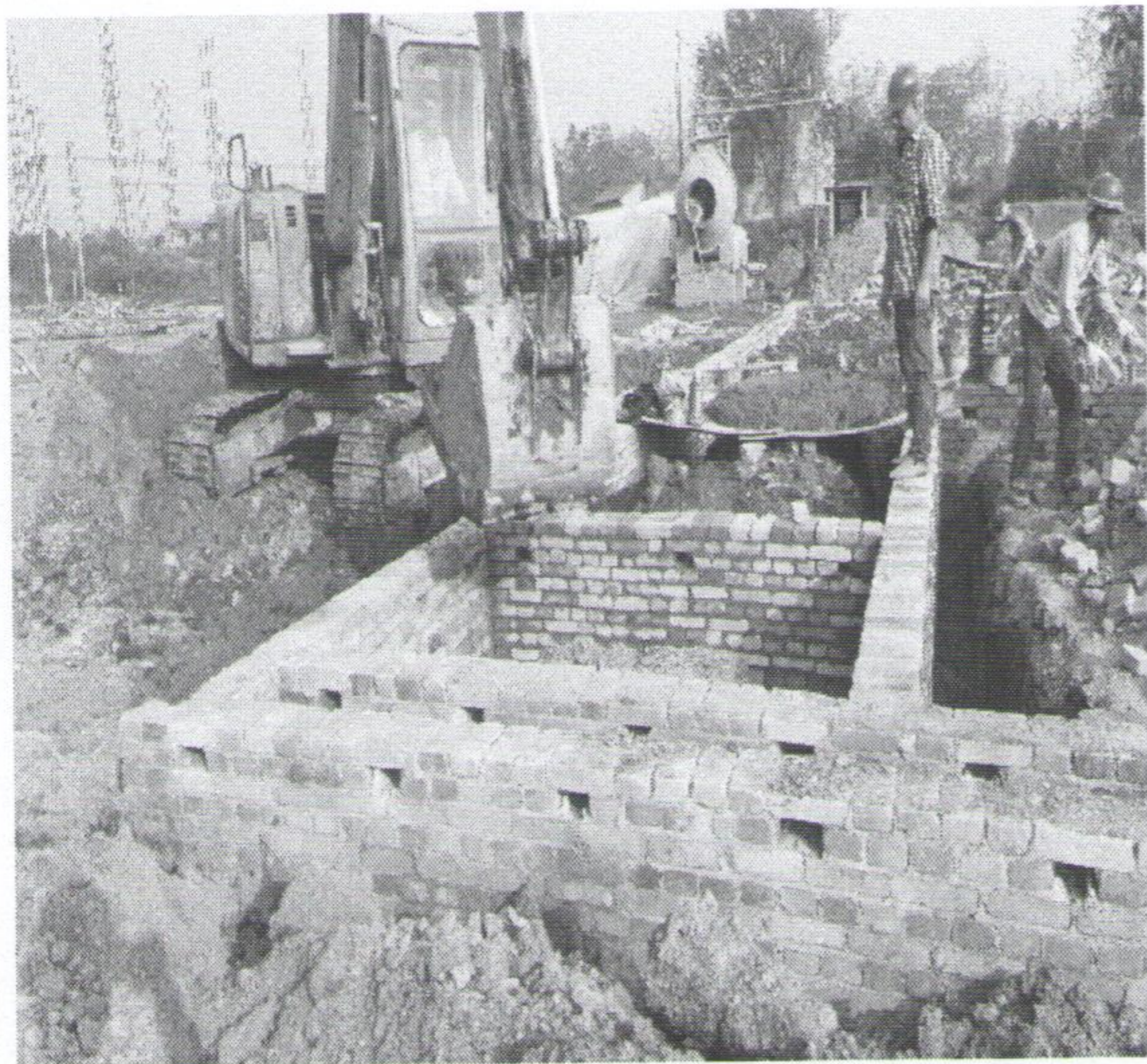
综合楼基础回填
