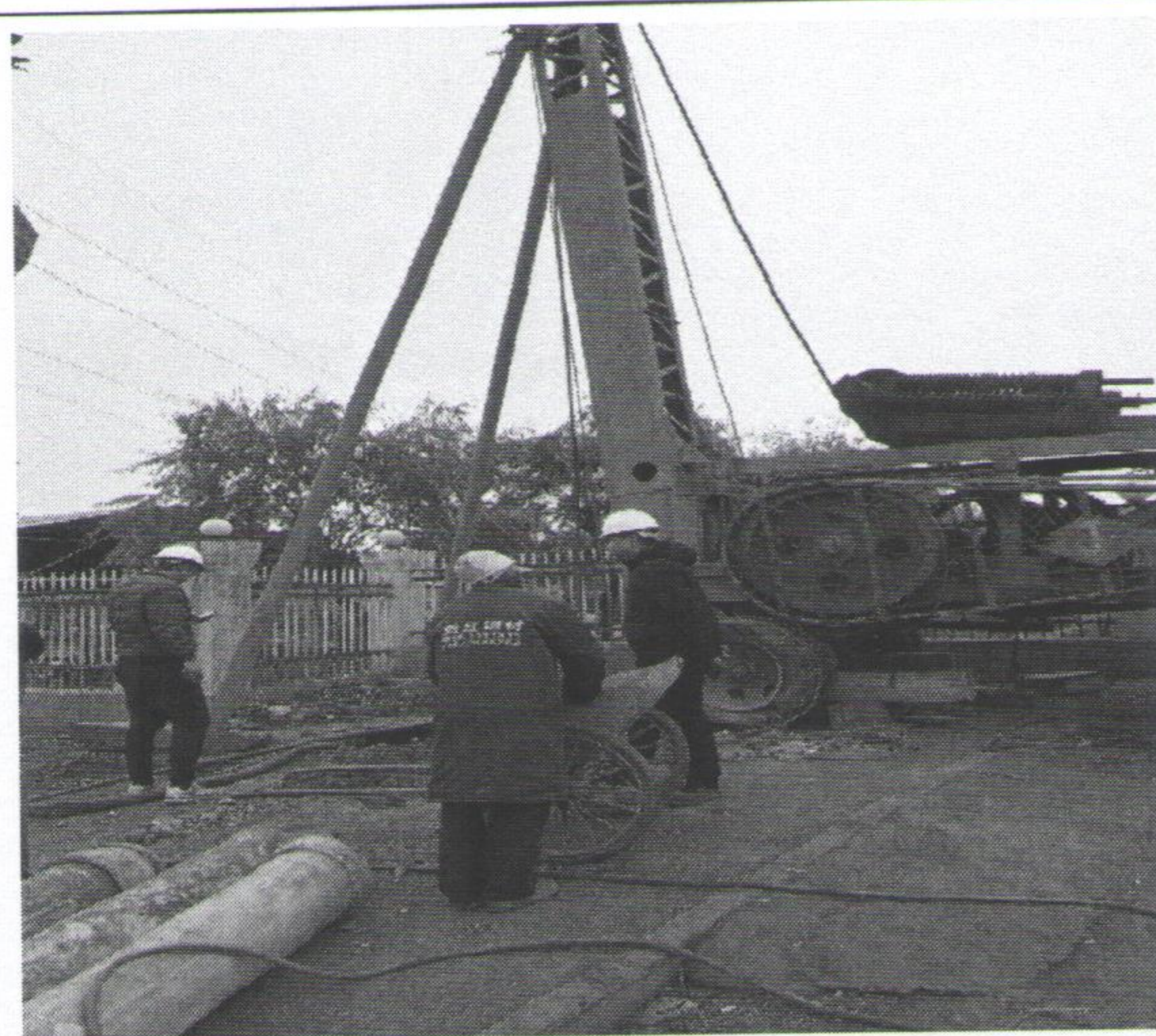
G37 基础开挖
