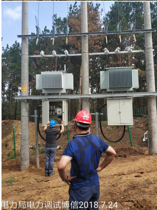
检查博信排水沟情况
