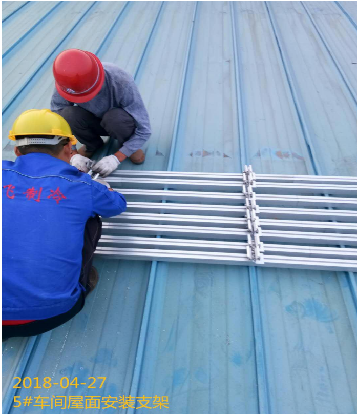
3、屋顶支架安装施工。
