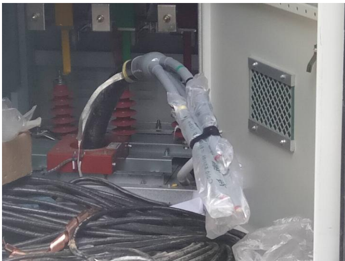
11、2018-05-28-高压电缆头制作完成
