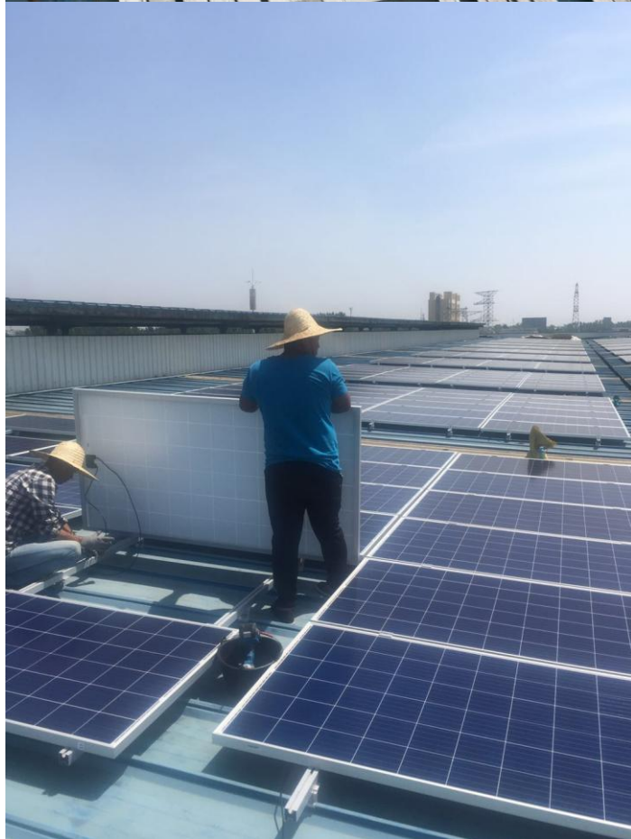
6、2018-05-08-5#车间屋面组件安装
