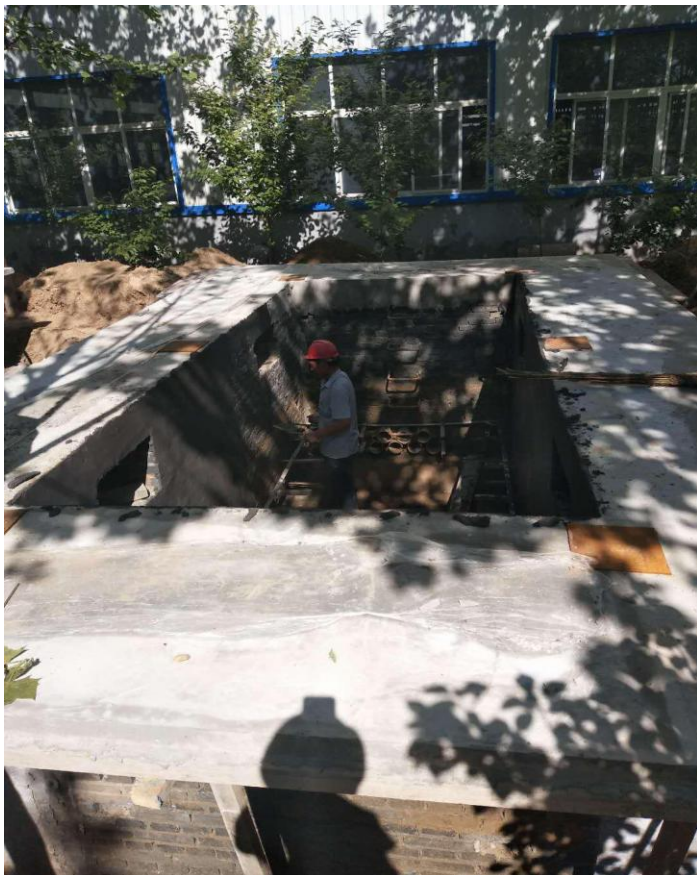
4、2018-05-04-设备基础墙体抹灰
