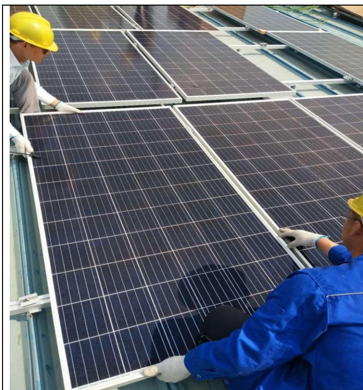
2、2018-05-02-5#车间屋面组件安装。
