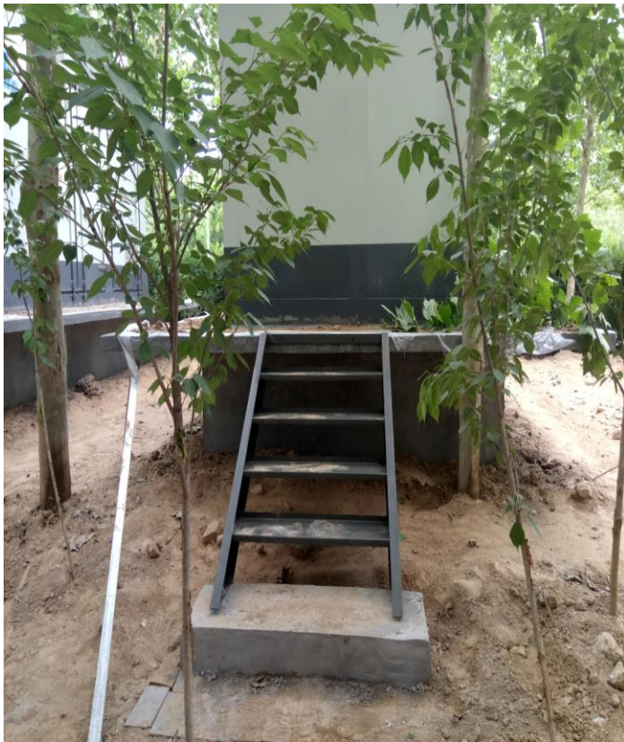
10、2018-05-15设备踏步安装完成
