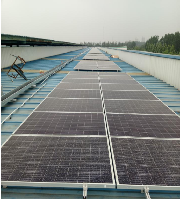
9、2018-05-15六号屋面组件安装
