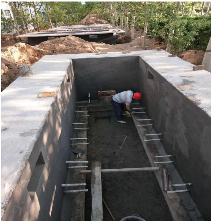
1、2018-05-02-设备基础墙体抹灰
