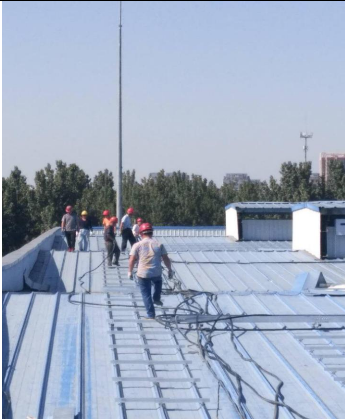
3、2018-05-03-屋顶敷设电缆
