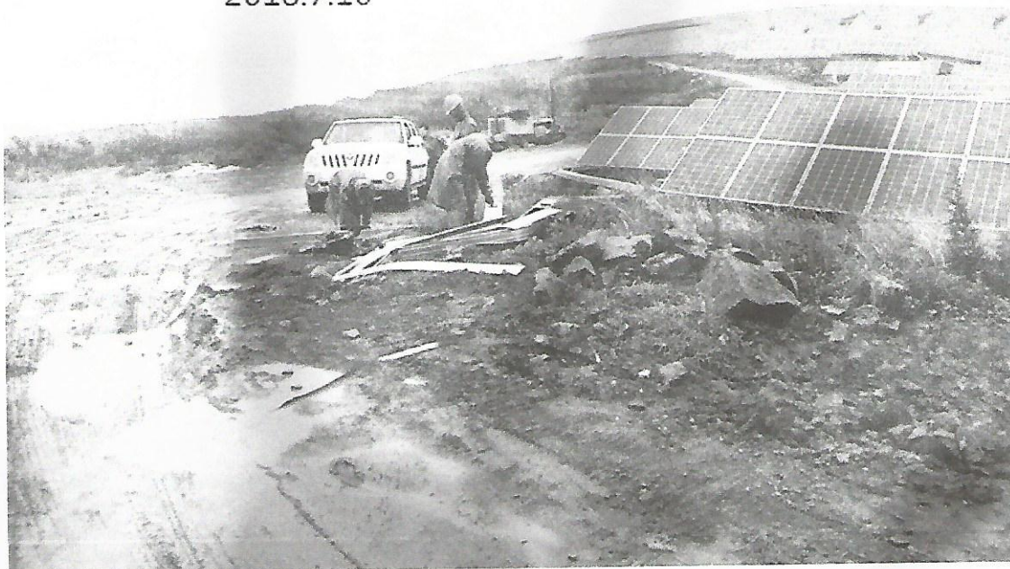
现场冒雨安装桥架 2018.7.10
