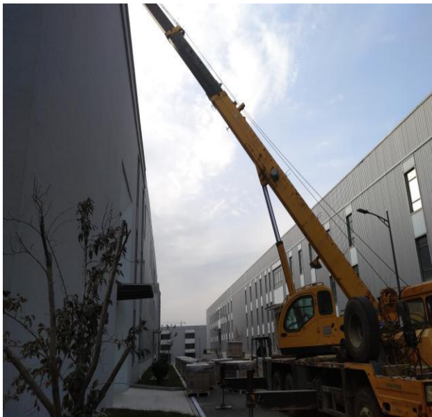
组件吊至D厂区 屋面
