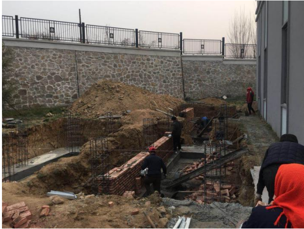
箱逆变基础墙 体砌砖
