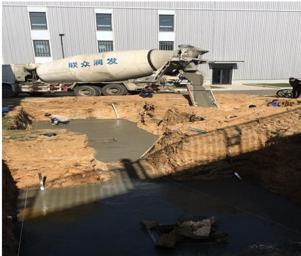
箱逆变基础垫 层浇筑
