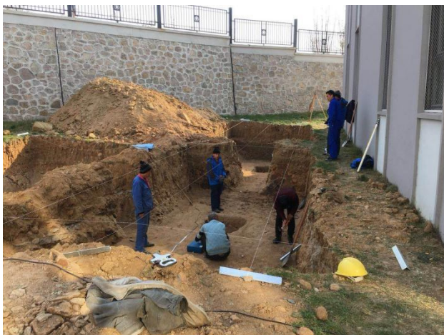
箱逆变基础定 位放线
