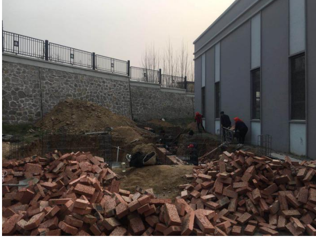
箱逆变基础墙 体砌砖
